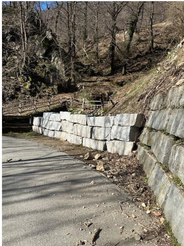
foto comparto dopo esecuzione opere urgenti
